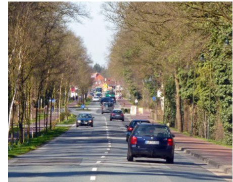
Erneuerung der Ortsdurchfahrt an der Wildeshäuser Straße
